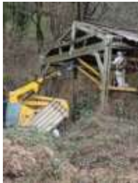
Photo 17 : Démantèlement d'un bâtiment amianté de l'ancienne champignonnière
