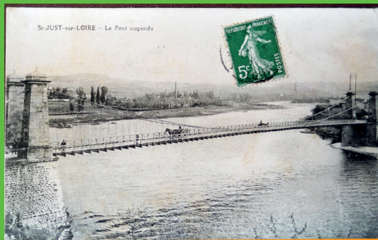
Ancien pont suspendu
